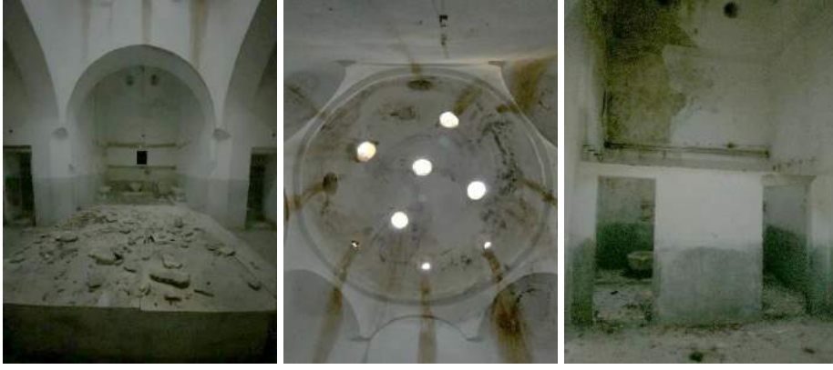
Şekil 3. Fertek hamamı sıcaklık bölümümlerinden görünüm (Özal, 2022).
