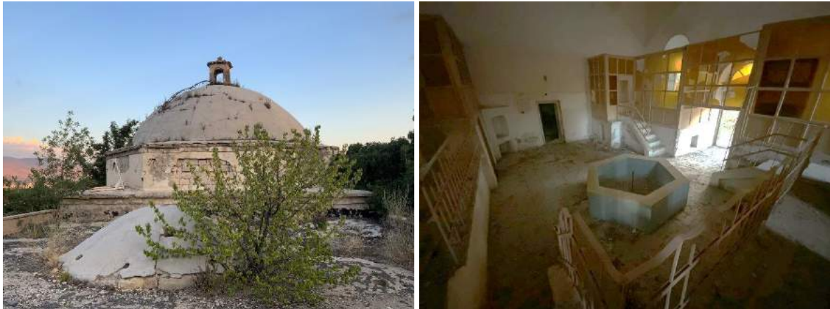
Şekil 2. Fertek hamamı güney cephesi aydınlık fenerinden görünüm ve soğukluk iç mekânı (Özal, 2022).
